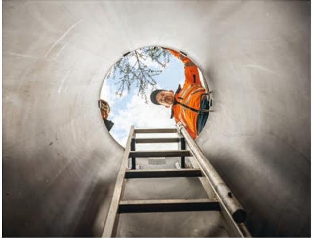
Das Grundwasser gelangt in eine sogenannte Freispiegelleitung. Sie nutzt natürliches Gefälle und transportiert so das Wasser mit nur wenig Energieaufwand.
